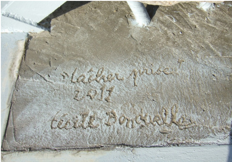
Bétonnage du socle avant recouvrement.
