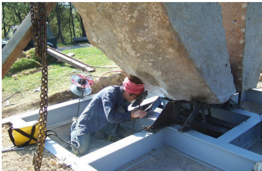
Souder encore, rajouter un sabot, souples. les fers à bétons de 43mm sont trop
